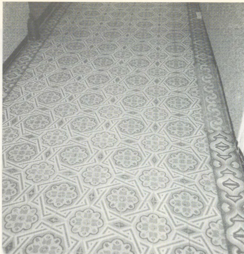
Gründerzeitliche Bodenfliesen im Eingang zum ehemaligen Speisesaal
