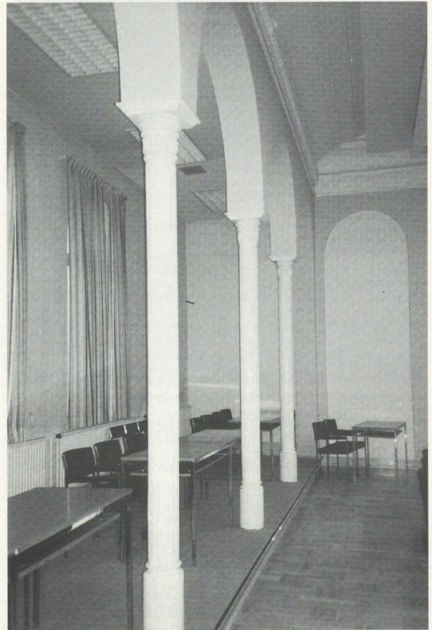
Rundbögen mit gußeisernen Säulen und Teil der stuckverzierten Decke im ehemaligen Speisesaal, dem heutigen Kreissaal
