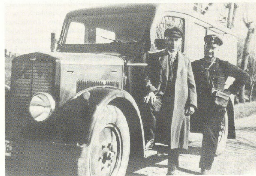
Landpostkraftfahrzeug mit Inspektor Kopper und Schaffner Hülsen
