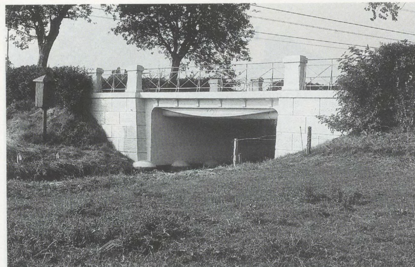
Brücke über die Bekau in Eversdorf, erbaut 1909. Von diesen Fischbauchbrücken sind nur noch 4 in Schl.-Holst. vorhanden.
