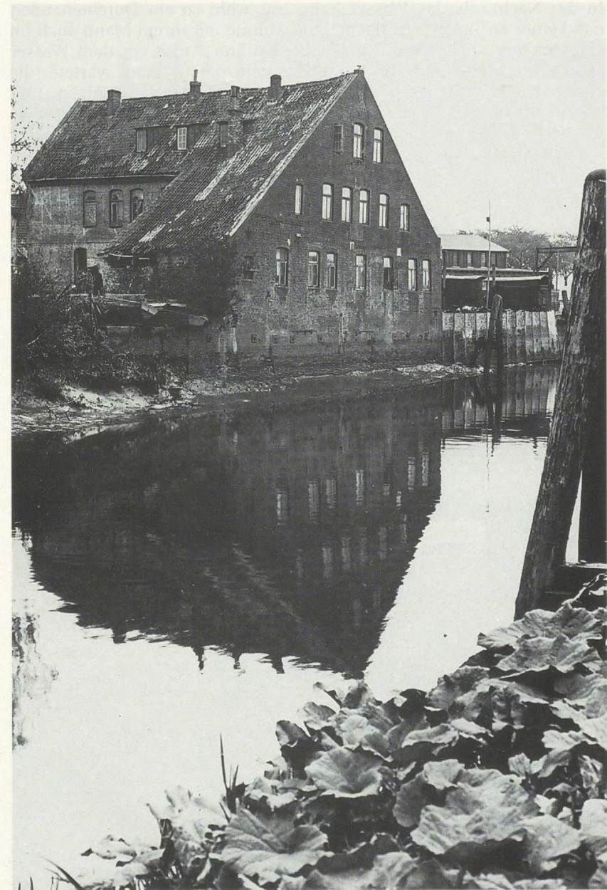
Fischerstraße 22 – das sogenannte Strandhotel. Hier in diesem Haus, das an der Stör stand, lebten die Armsten der Armen.
