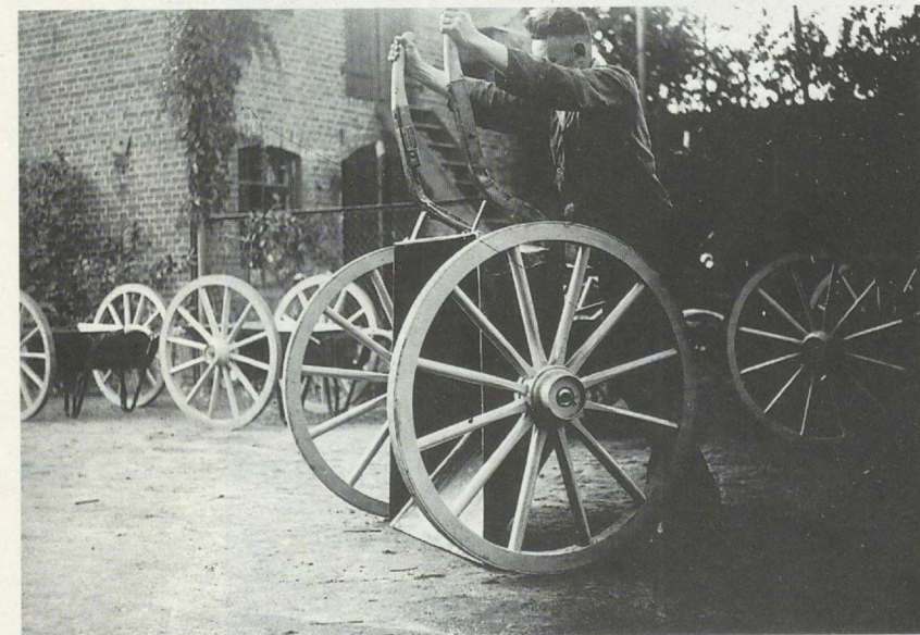
Serienmäßig hergestellte Schotterkarren für den Straßenbau
