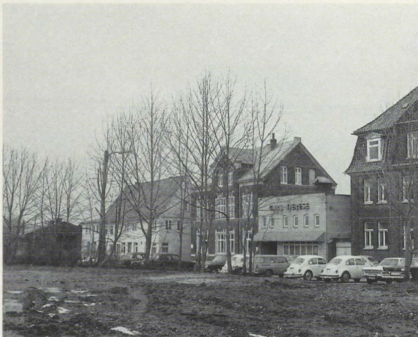
Die Fotografie entstand während der Zeit der „Neustadtsanierung“ (70er Jahre des 20. Jahrhunderts). Rechts ist das 1909 errichtete Polizei-, Gefängnis- und Verwaltungsgebäude zu erkennen, das die trotz der Rathäuserweiterung von 1893 weiterhin bestehende Not an Verwaltungsräumen beheben sollte. Daneben ist mit moderner Fassade die Handlung Tierese zu erkennen. Den Abschluß des Straßenzugs „Markt“ bildeten die Gebäude der Schankwirtschaft Finckelmann.
