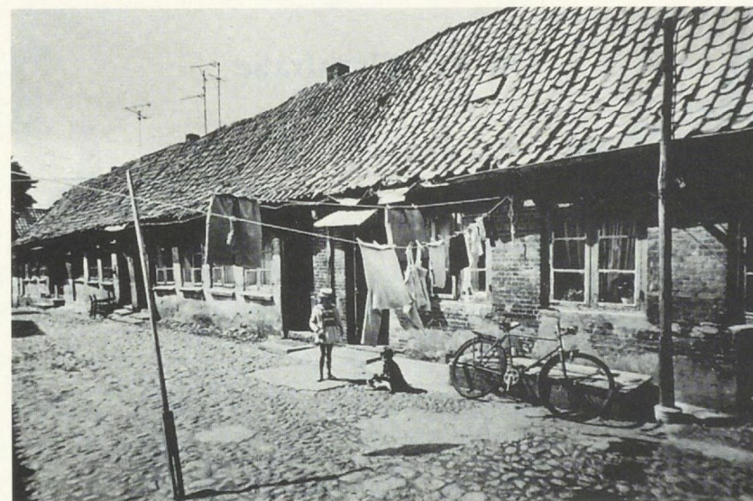
Fischerstraße 1–3. Auf dem Hühnerhof lebten arme Leute. In den Wohnungen gab es keinen Strom und auch kein fließendes Wasser. Wasser wurde unten von der Straße geholt, wo zwei Wasserhähne angebracht waren. Auch die Wäsche wurde vor Ort gewaschen. Das Abspülwasser wurde einfach aus dem Küchenfenster geschüttet.
