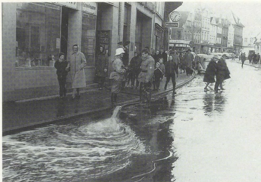
Pumparbeiten in der Breiten Straße
