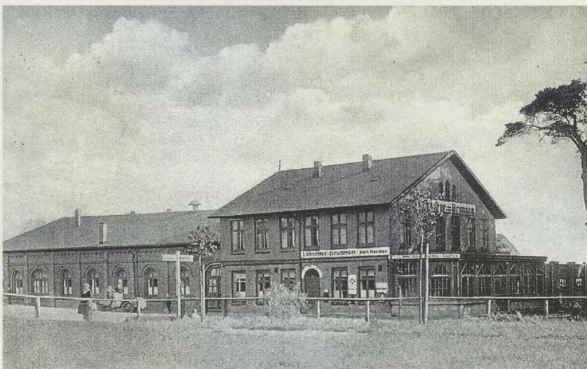
Itzehoe, Lübscher Brunnen, Außenansicht
