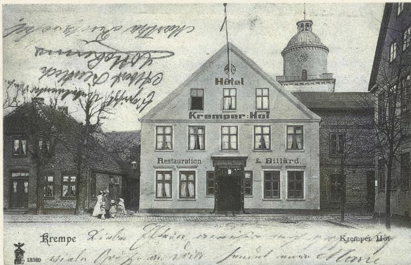
Hotel Kremper Hof, Außenansicht
