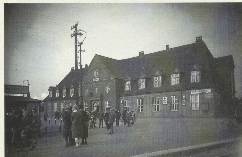
Historische Aufnahme der „Bahnhofsgaststätte“ (aus den 20er Jahren) vom Bahnhof Wilster (heute leerstehend)
