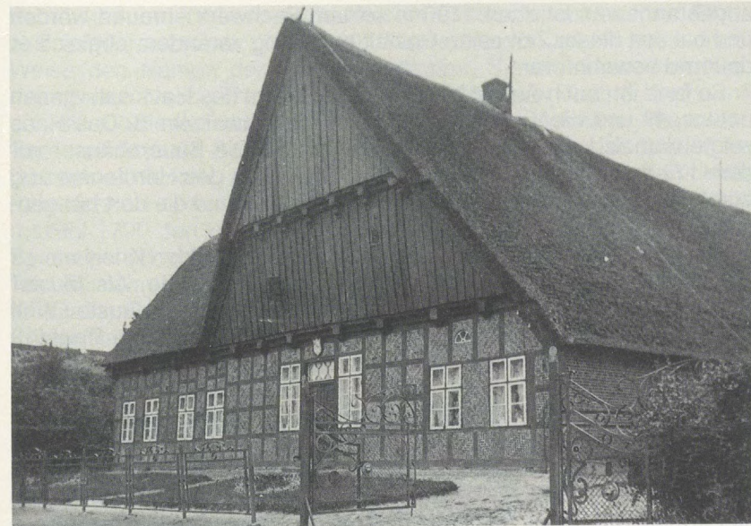
2. Rohlfs Hof, ein Husmannshus als Halbkreuzhaus, Nordseite. (Foto Möller)
