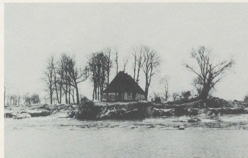
Das Uhrendorfer Fährhaus, an dessen Warft die Sturmflut von 1962 deutliche Spuren hinterlassen hat. Das Gebäude selbst ist bald nach dieser Aufnahme abgebrochen worden. (Sammlung H. Karting)
