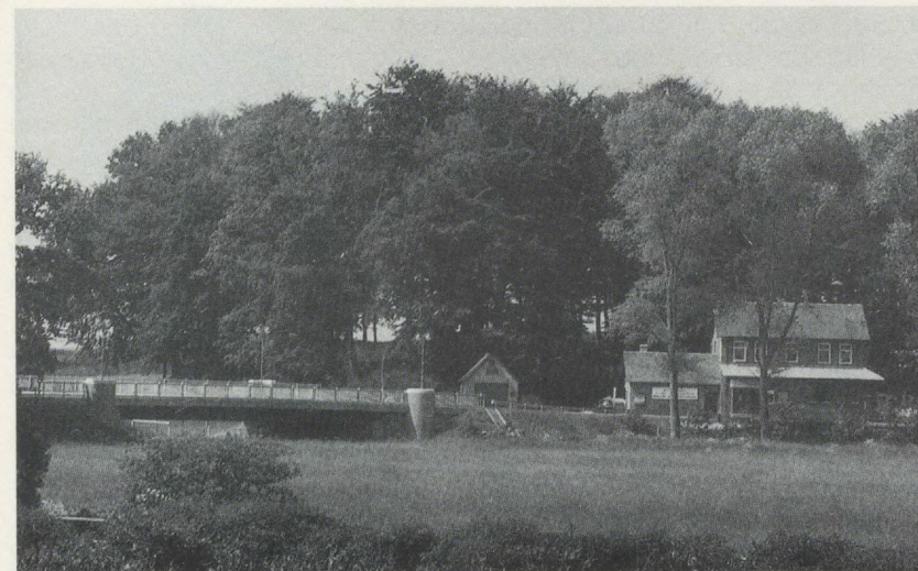
Der gleiche Blick 1991. Trotz der Erneuerungen sind sich die Bilder sehr ähnlich.
