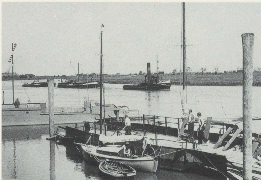
In den zwanziger Jahren erhielt auch Beidenfleth einen neuen Fährprahm. Das zur Reserve im Vordergrund liegende alte Fahrzeug wurde von Sportseglern gern als Anleger benutzt. Auf dem Strom ein störabwärts fahrender Schleppzug mit Zementleichtern und dem Schlepper „Krückau“ der Firma Alsen. (Sammlung H. Karting)
