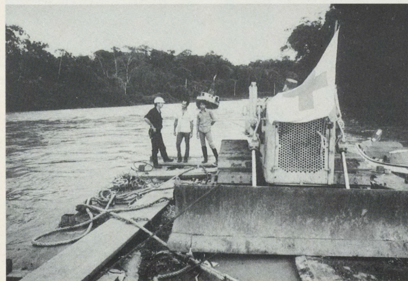
Die Seilwinde eines Bulldozers hilft bei der Bergung der „GRÖPELN“, November 1986 (Foto: Slg. Claus Ferner, Bremen)
