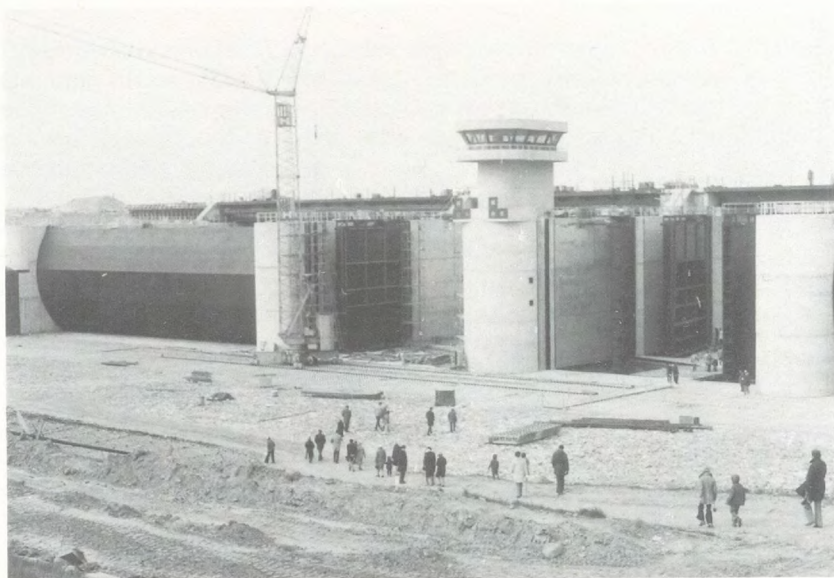
Das Störsperrwerk vor der Fertigstellung im Jahre 1974
