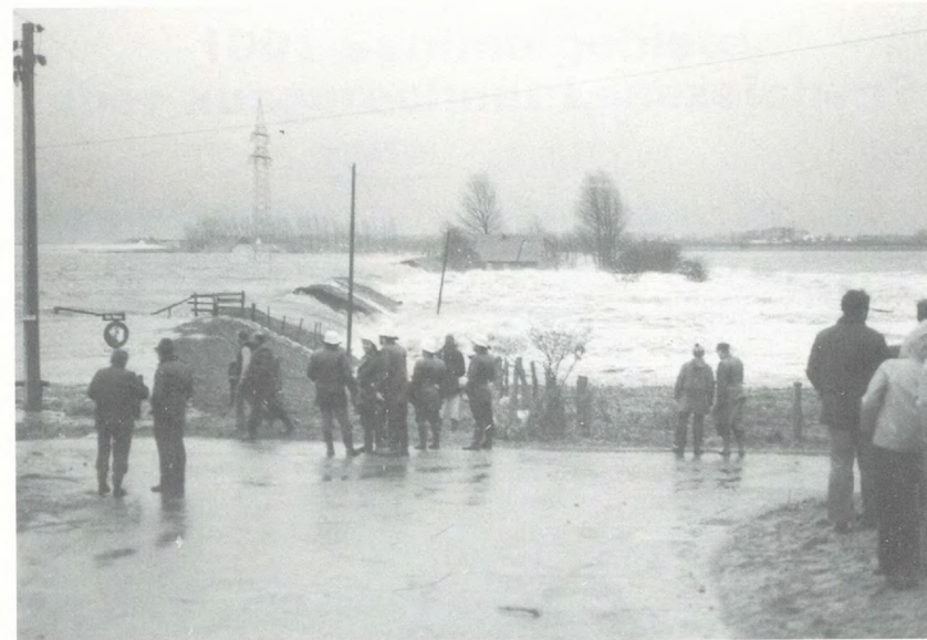
Bruch des Landesschutzdeiches vor der Haseldorfer Marsch am 3. Januar 1976
