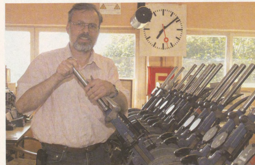
Jürgen Friese hat von Museums-Initiator Horst Theis inzwischen faktisch die Leitung der Ausstellung übernommen. Hier steht er an einem Kernstück des Stellwerks, den Hebelbänken für die Steuerung von sechs Signalen und 14 Weichen. (Foto: Björn Marnau)
