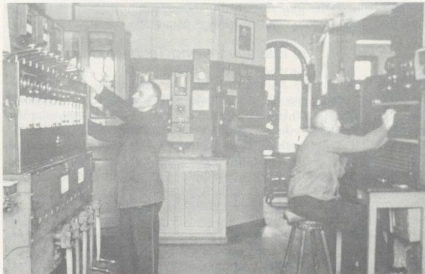
Schon in der Zwischenkriegszeit wurde über das sogenannte Blockstellwerk der Zugverkehr im Schienennetz koordiniert, das in Blockabschnitte unterteilt ist. Fährt ein Zug in einen Abschnitt, wird dieser über ein Signal für alle anderen Züge blockiert. (Foto: Eisenbahnstellwerk-Museum)
