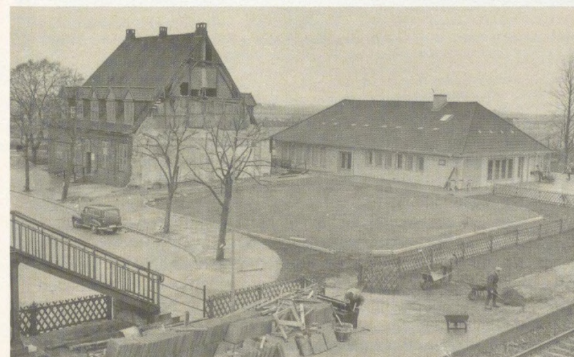
Dieses Foto von 1959 zeigt rechts den dritten Bahnhof, an dem noch Restarbeiten durchgeführt wurden und den Nordflügel des zweiten Bahnhofs. In diesem Gebäuderest des bereits weitgehend abgerissenen Bahnhofs von 1919 wurde bis zur Fertigstellung des Ersatzgebäudes der Schalterbetrieb provisorisch abgewickelt. Foto: Schult
