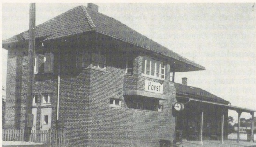
Stellwerk mit Bahnhofsgebäude 1934
