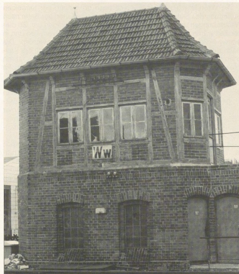
Dieses Gebäude stand unmittelbar westlich auf der Nordseite des Bahnübergangs Burger Straße. Es diente zur Signalführung und Sicherung des dortigen Bahnübergangs. Kurz nach der Umstellung des Bahnübergangs etwa 1982 auf automatische Halbschranken wurde das Gebäude abgerissen. Foto: W. Schröder
