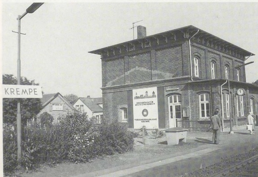
Das neue Empfangsgebäude nach Entfernung des Güterschuppenanbaus 1988
