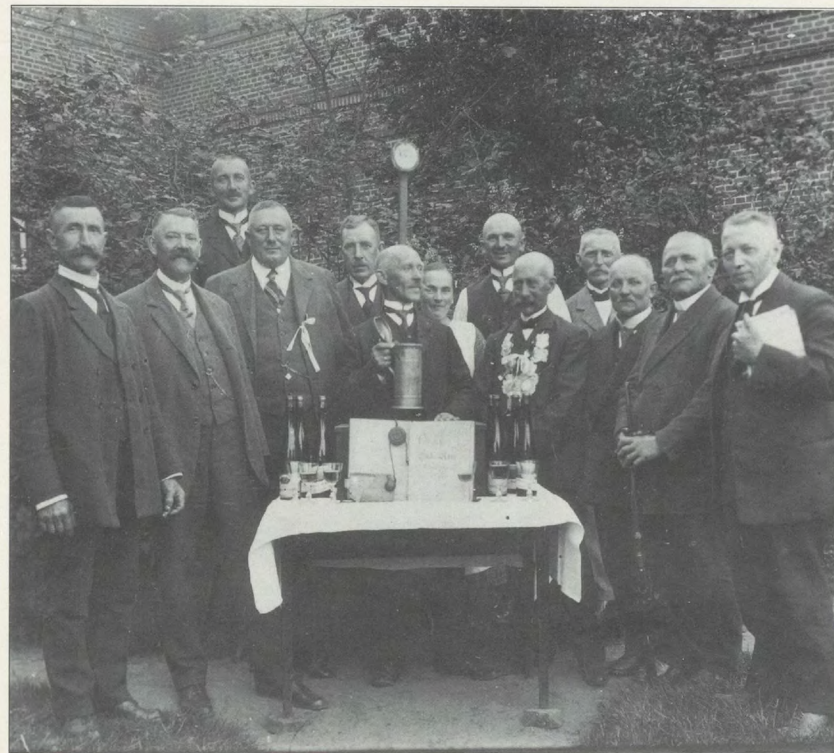
Vorstand der Gilde kurz nach 1900. Auf dem Tisch sind die beiden wichtigsten und die historischen Wurzeln belegenden Insignien und Existenzbeweise zu sehen: die Gildelade mit der darüber ausgebreiteten und am Siegel erkennbaren Gilderolle. Der geöffnete Zinnkrug in der Hand des Ältermannes spielt am Beerpröwabend eine entscheidende Rolle. Selbstverständlich dürfen die Weinflaschen nicht fehlen, da am Abend nicht mehr Bier getrunken wird. An der rechten Seite des Tisches ist der Gildekönig an seiner Königskette zu erkennen. Umgeben wird er vom 2. und 3. König sowie den anderen Honoratioren dieses denkwürdigen Tages.
