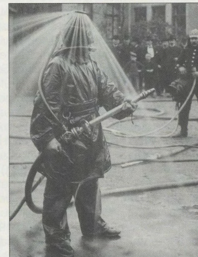
li: Rauchhelm der Firma König aus Altona von 1905, Foto: FMSH re: Demonstration des Rauchhelms der Firma König aus Altona auf dem Hof der Zentralfeuerwache Altona in der Mörkenstraße im Jahr 1890, Foto: FMSH
