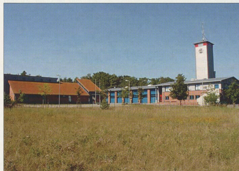
Die Kreisfeuerwehrzentrale in Breitenburg-Nordoe
