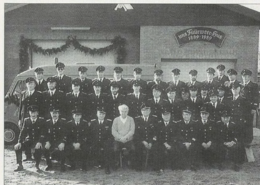
Erweiterung des Feuerwehrhauses 1989
