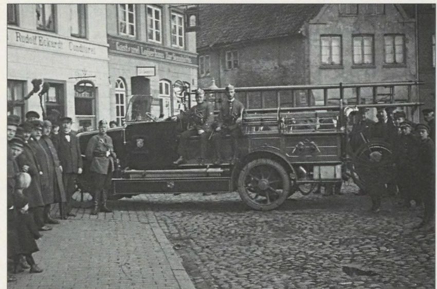
„Automobilfeuerwehrspritze“ der Freiwilligen Feuerwehr. Sie wurde am 18. November 1926 angeschafft und war bis in den Anfang der 50er-Jahre im Dienst, also rund 30 Jahre lang. 42 PS, 1200 l/min., Lenkrad rechts, Vollgummibereifung. Foto etwa 1930
