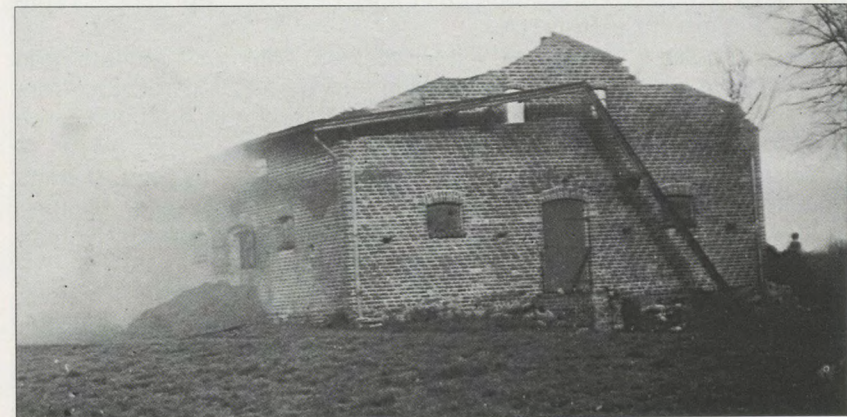
Der rückwärtige Teil des zerstörten Stalls am 17.11.1940. Quelle: Archiv der Freiwilligen Feuerwehr Horst (Holstein). Fotograf unbekannt.
