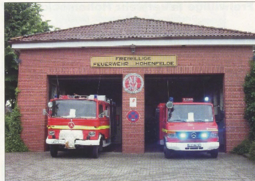
Fahrzeughalle mit Einsatzfahrzeugen
