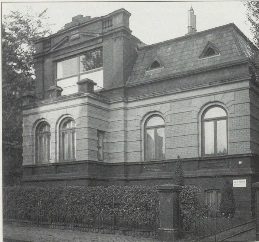
Abb. 3 Straßenansicht mit gründerzeitlicher Fassade. Das große Atelierfenster im Obergeschoss ist bereits eingebaut, Aufnahme ca. 1926 (Wenzel-Hablik-Stiftung, Itzehoe).
