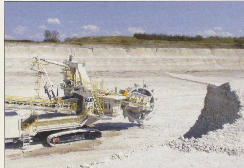
Der Schaufelradbagger in der Heidestraße hat „Pause“. Im Vordergrund ist schön zu sehen, wie er sich rund durch die Kreide „frisst“.
