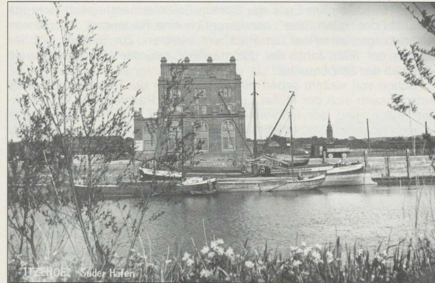
Das Mühlengebäude von Rusch, um 1900
