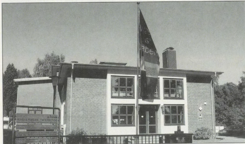
Das Wasserwerk Twietberg, 2005
