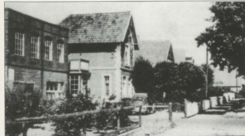
Sperrholzfabrik Heumann und Verwaltung, (Quelle: Ansichtskarte)
