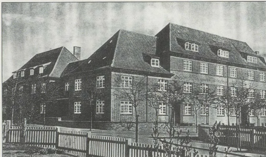
Hebbelstraße 6 und 8 bis Stormstraße 12 (Dachlandschaft)
