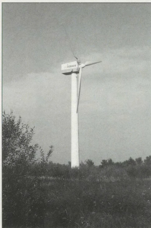
Windkraftanlage der Stadtwerke
