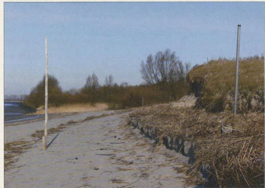
Abbrüche am Westufer nach Elbvertiefung von 1998/99 (Foto: Frank Allmer)
