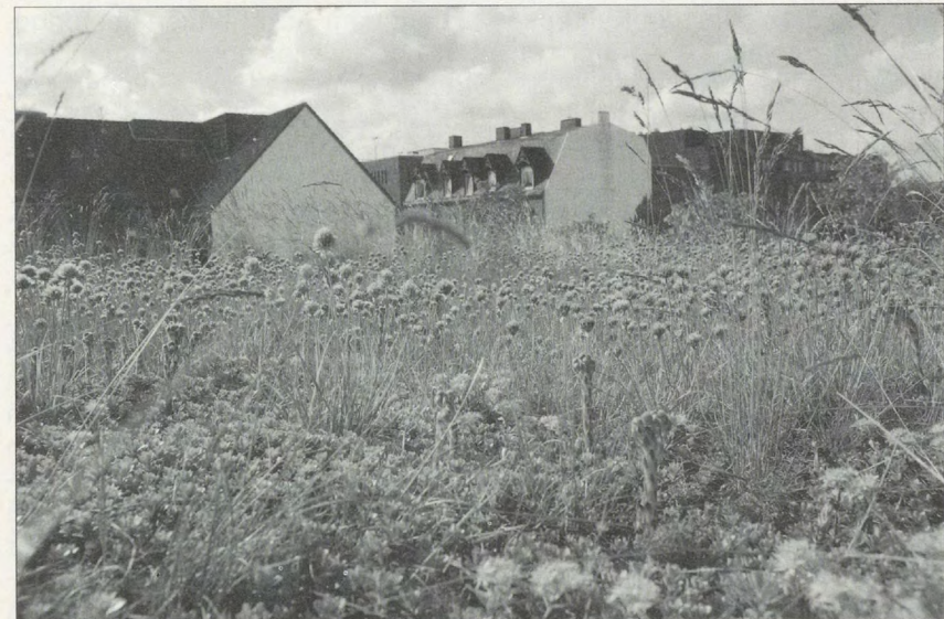
Dachbegrünung BUND-Geschäftsstelle in Kiel
