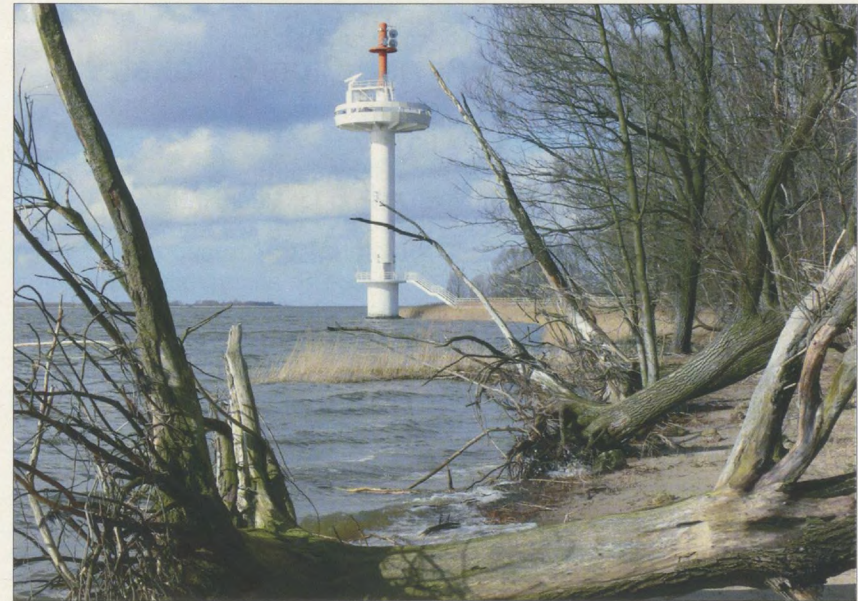
Nach der Elbvertiefung von 1998/99 werden immer wieder die Wurzeln alter Uferbäume unterspült (Foto: Frank Allmer)
