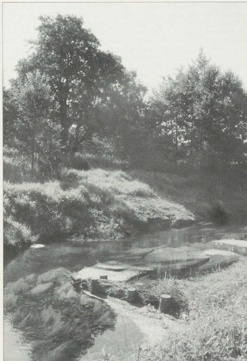
Blick bachabwärts auf Strömungsenker aus Faschinen kurz nach dem Einbau. Am linken Ufer wurde die Grasnarbe der Böschung entfernt, um die Erosion zu fördern (Foto H.-U. Schimkat, 17.8.2008).
