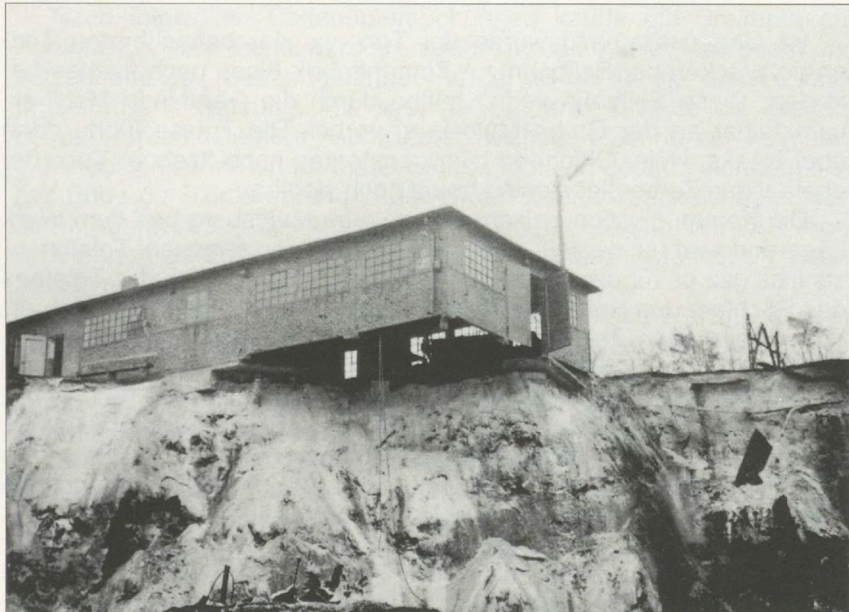
Obwohl Teile des Untergrundes fehlen, steht die Schlosserei noch.
