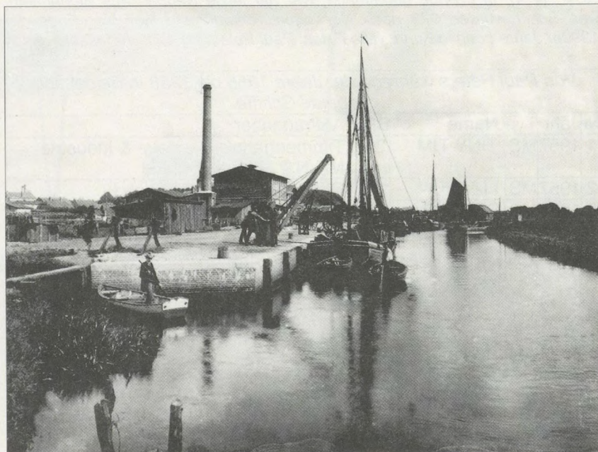
Der städtische Lös- und Ladeplatz, Blick störaufwärts nach Osten Aufnahme: Detlev Vahlendick, vor 1911. Archiv Museum Kellinghusen
