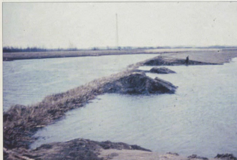
Deichbruchstelle bei Münsterdorf (Foto: Vf.)
