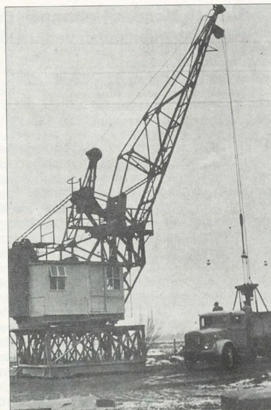
Der alte Gleichstrom-Kran (1953 stillgelegt)
