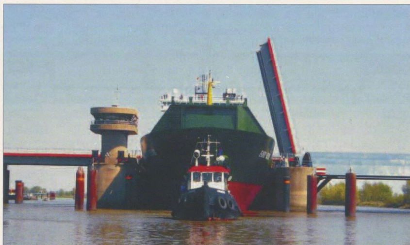
Schiffspassage durch das Sperrwerk
