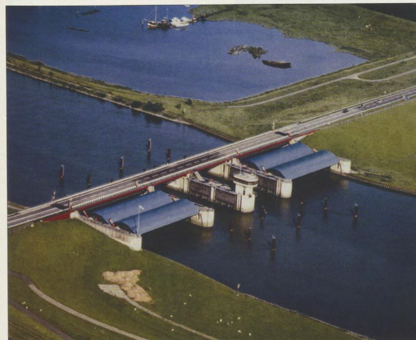
Störsperwerk nach der Fertigstellung
