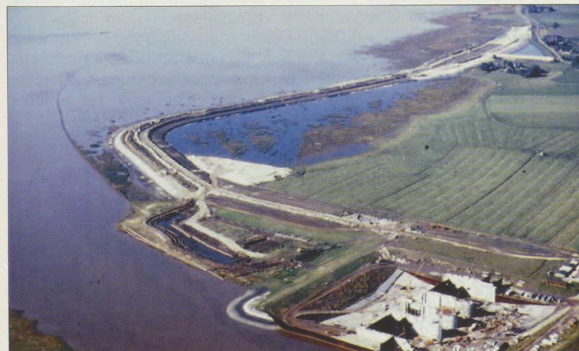
Baustelle Deichbau und Sperrwerk
