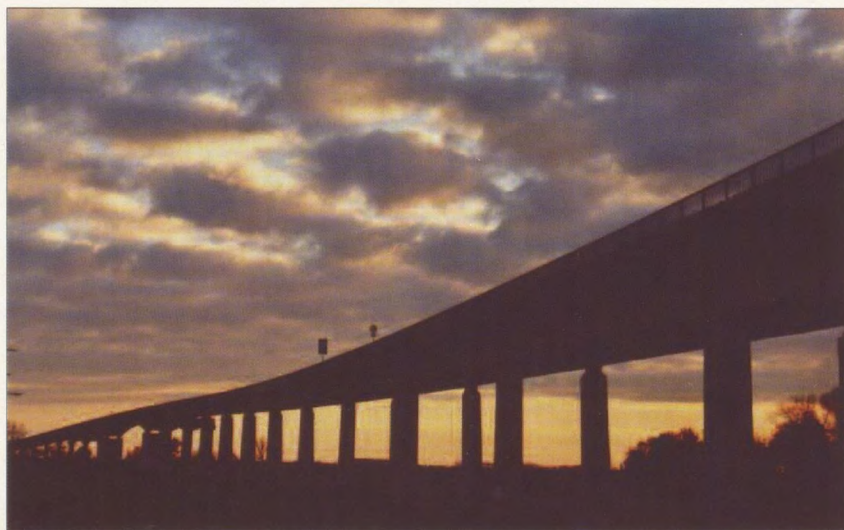
Bisherige Autobahnbrücke über die Stör
