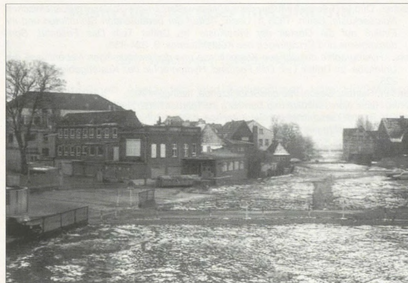
Rückseite der Gebäude Breite Straße 42-44 mit Blick auf die zugeschüttete Störschleife
