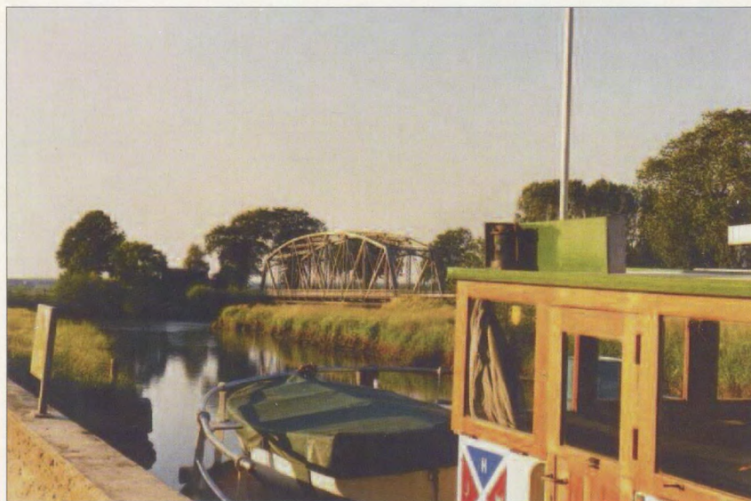
Wittenbergen: Hafen mit alter Straßenbrücke (1988)
