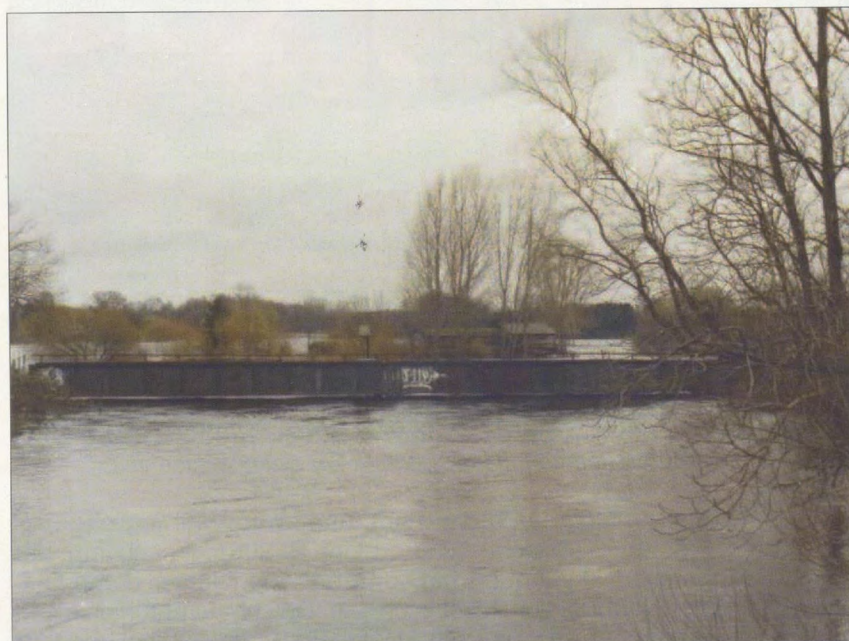
Ehemalige Eisenbahnbrücke (Februar 2002)
