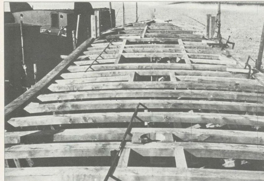
In den ersten Nachkriegsjahren wurde ausschließlich Holzschiffbau betrieben. An Stahlschiffen waren lediglich Reparaturarbeiten gestattet.
