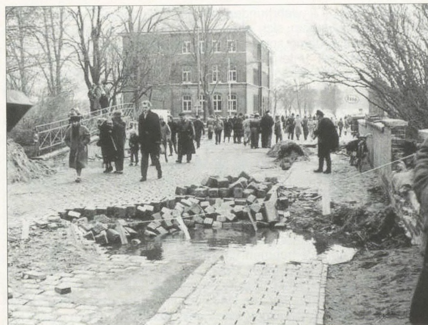
Sturmflutschäden im Bereich der Delftorbrücke 1962
